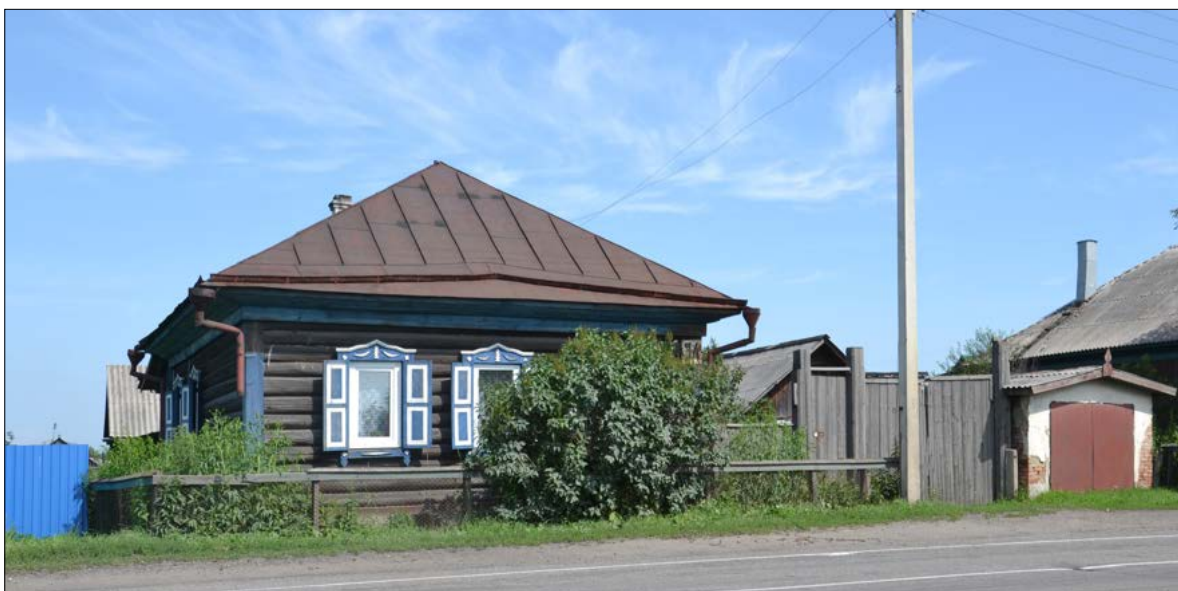
Рис. 12. Фасад усадьбы, с. Атаманово (Новокузнецкий район), фото 2015 г.
