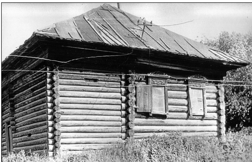
Фото 1. Дом-связь на подклети.
